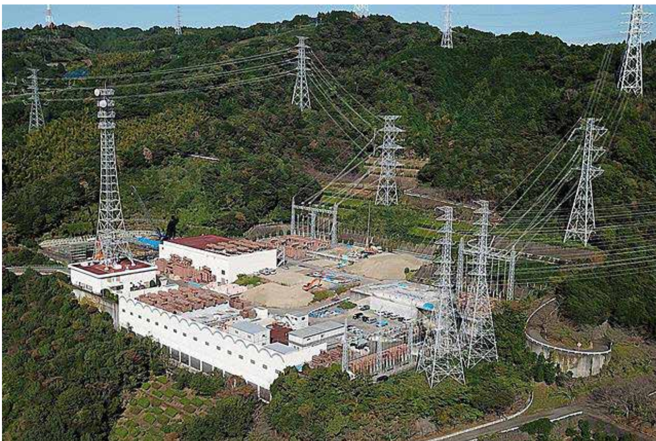
Stația electroenergetică Higashi-Shimizu a companiei Chubu Electric Power din Shizuoka, Japonia
