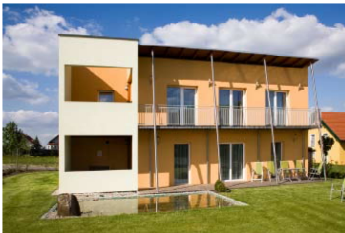
Figura 3 – Casa pasivă Schiller – Großschönau
